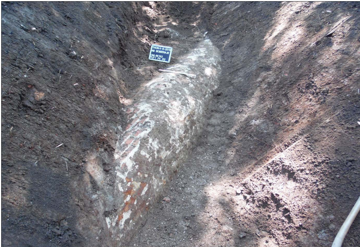
Afbeelding 18. Het oostelijk segment van het riool dat tijdens de graafwerkzaamheden werd aangesneden (Spoor nr. 2).
