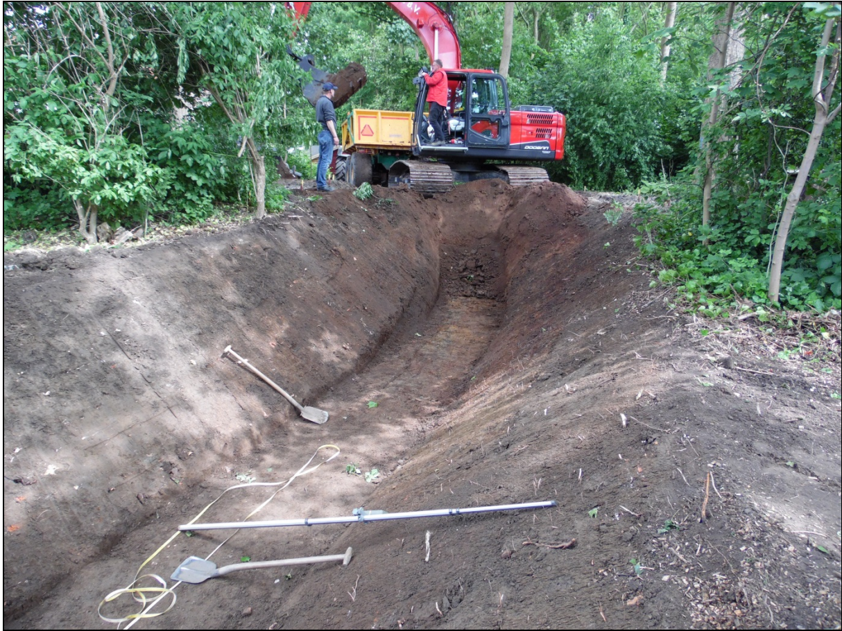
Afbeelding 11. Een voorbeeld van de graafwerkzaamheden, waarbij de sleuf met bochten en met een talud werd aangelegd. De aanwezigheid van bomen bemoeilijkte het documenteren door middel van een GPS.
