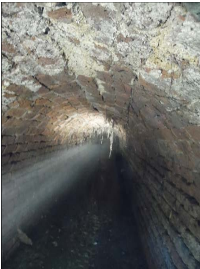
Afbeelding 20. De binnenzijde van het riool (Spoor nr. 2). De foto is genomen vanuit westelijke richting.
