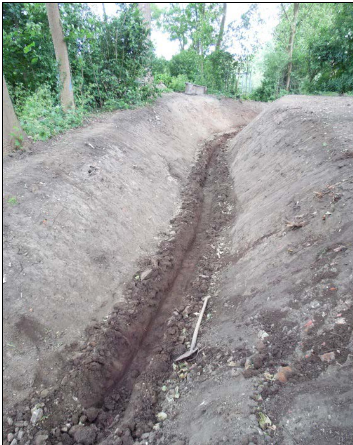
Afbeelding 9. Het smalle sleufje voor het plaatsen van de drainagebuis.
