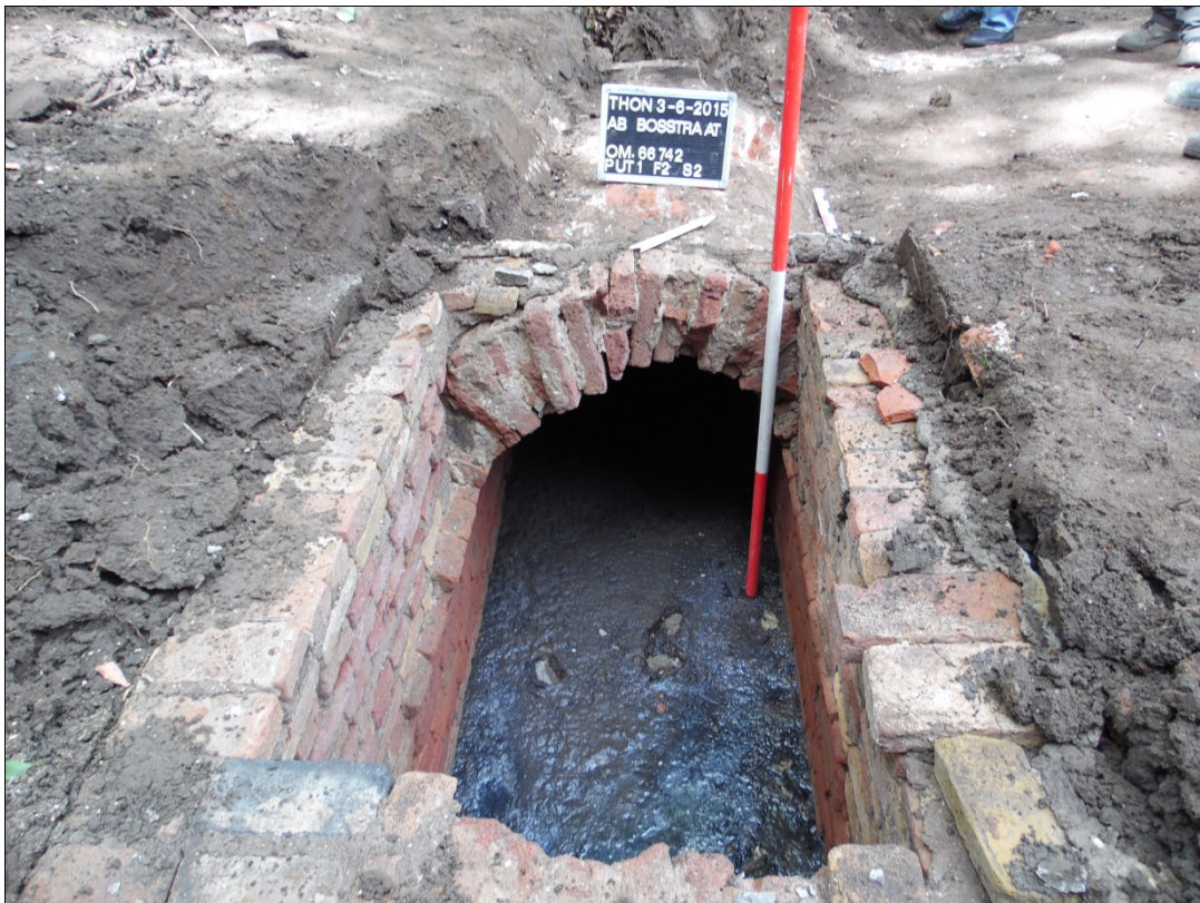
Afbeelding 22. De onderhoudsingang na het verwijderen van de betonnen dekplaat (Spoor nr. 2).
